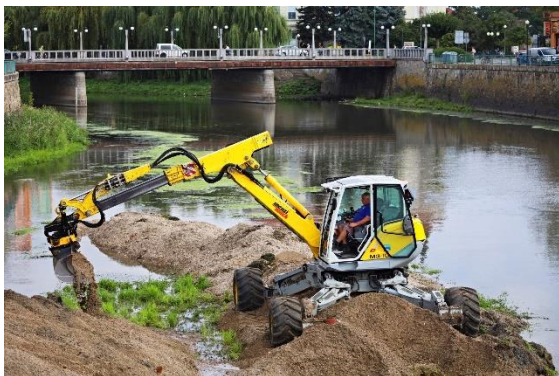
Úprava koryta řeky Dyje.
