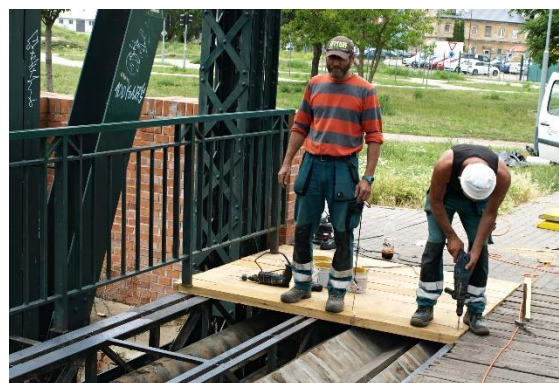
Oprava cukrovarské lávky.
