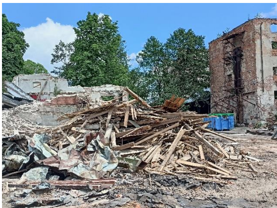
Demolice Vránova mlýna.
